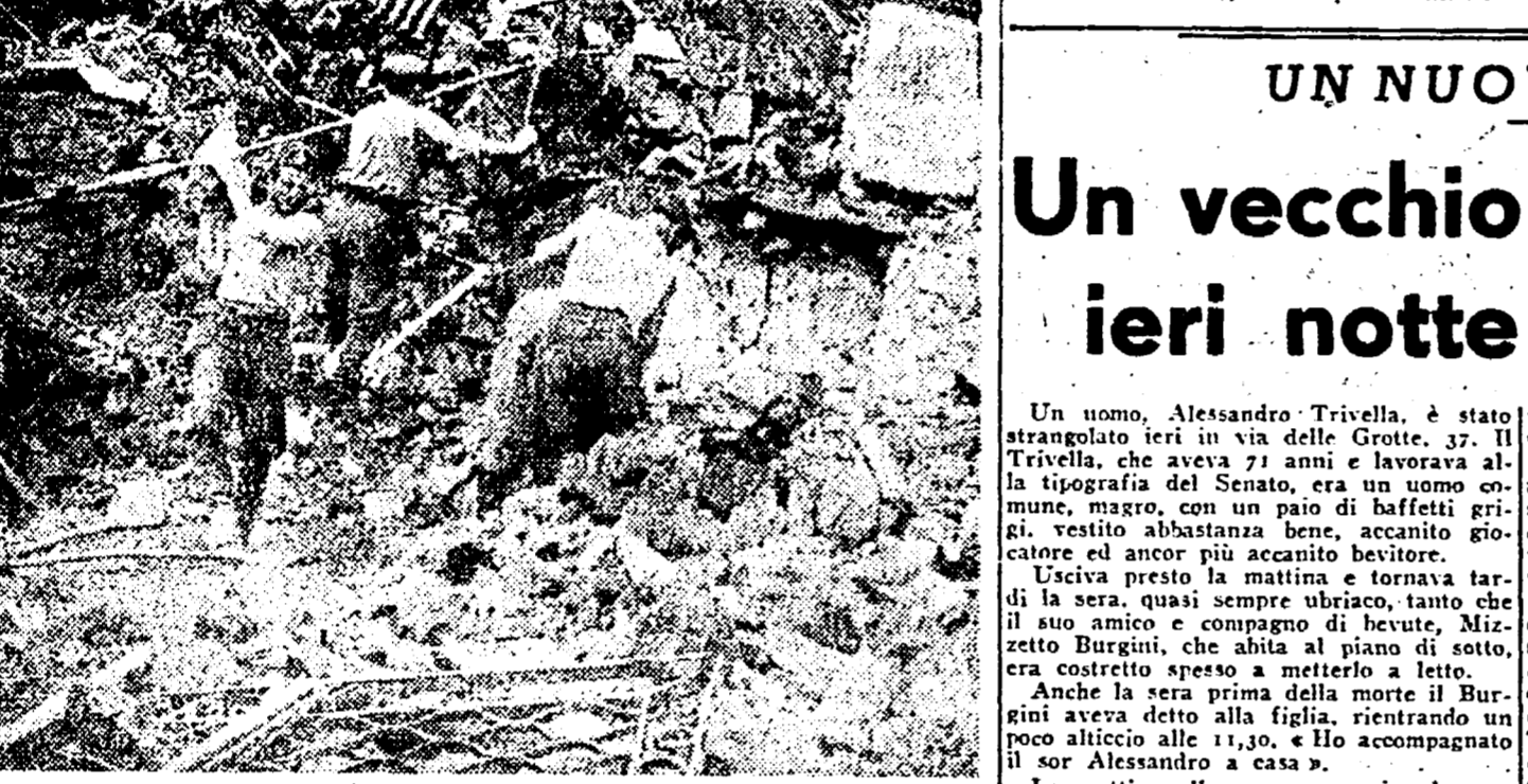
I Vigili del Fuoco lavorano indefessamente per rimuovere le macerie. Ecco come si è ridotta la parte posteriore dell'edificio della «Minerva». A sinistra si vedono i resti di una casa adiacente.
