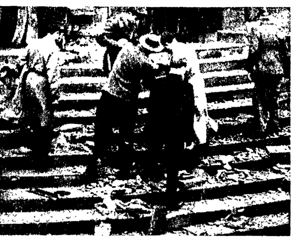
L'ingresso della sede della Federazione comunista milanese dopo lo attentato fascista del 25 settembre scorso
