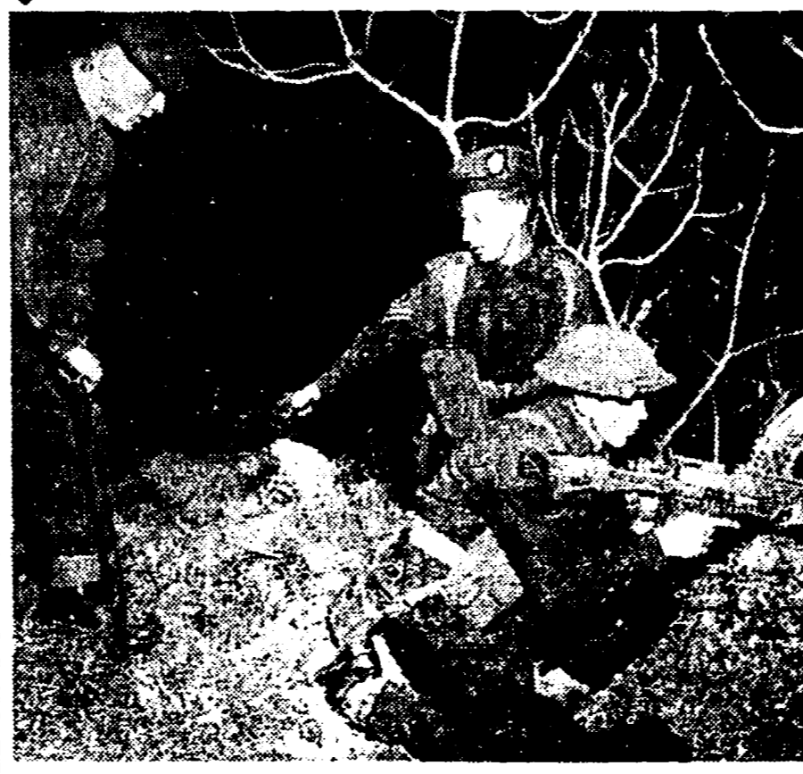
Scavando trincee e costruendo postazioni per mitragliere nella zona di Trieste, gli anglo-americani lavorano « per la pace »
