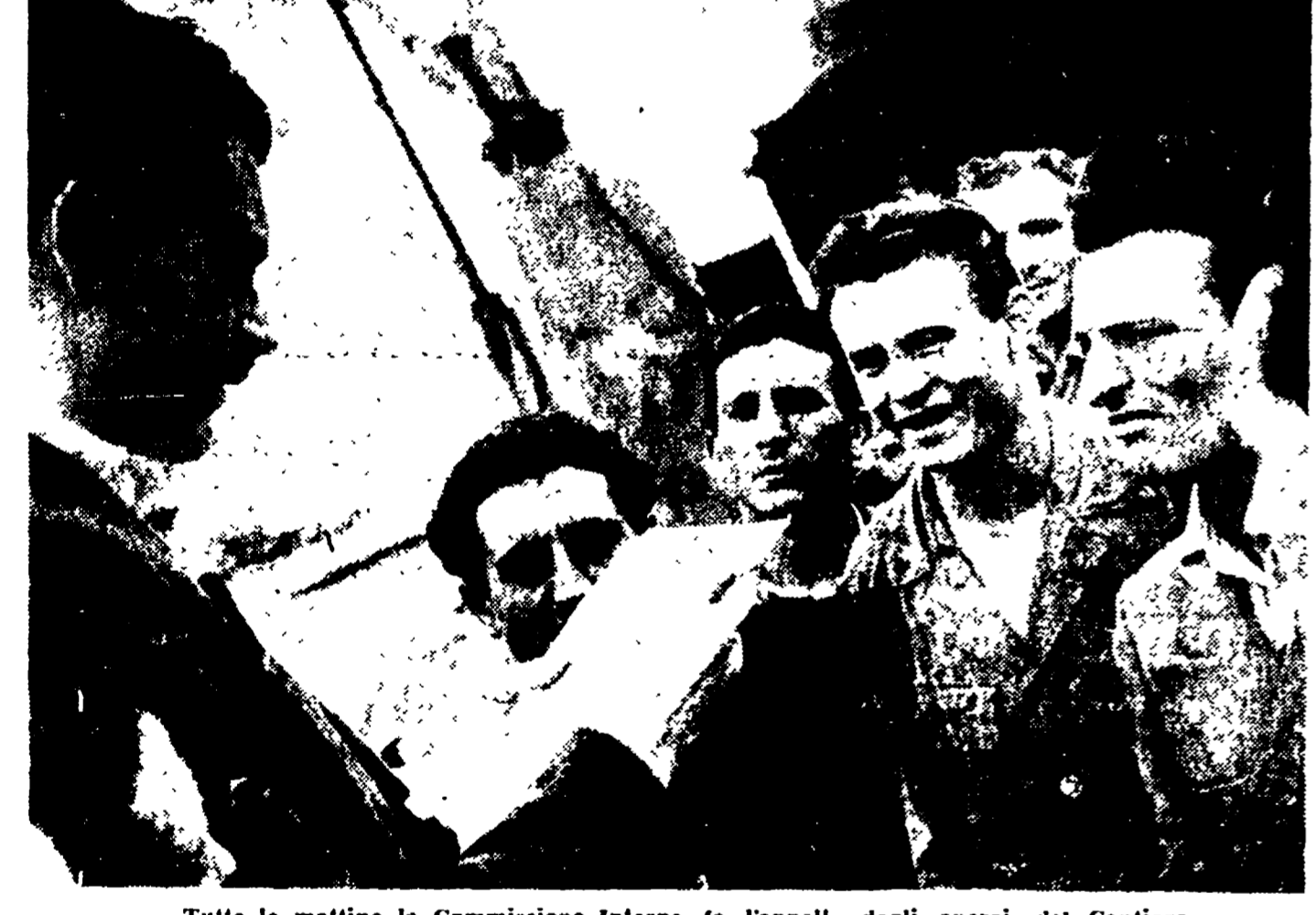
Tutte le mattine la Commissione Interna fa l'appello degli operai del Cantiere
