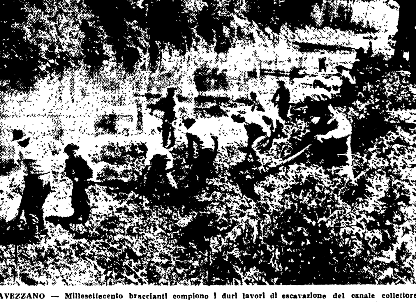
AVEZZANO — Millesettecento braccianti compiono i duri lavori di escavazione del canale collettore nel Fuclno. La lotta per il pane e contro lo sfruttamento di Torlonia continua
