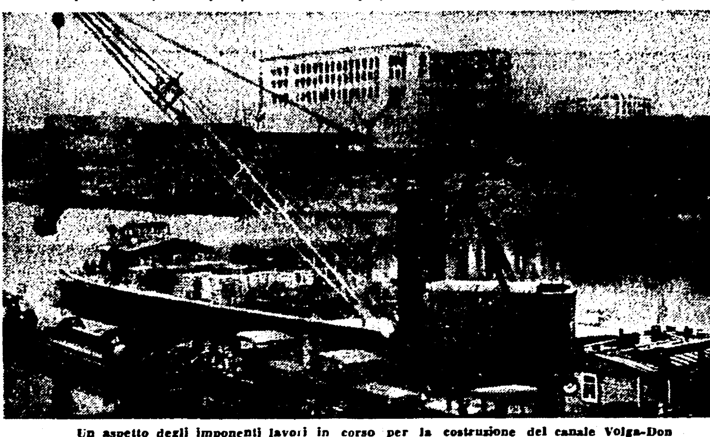
Un aspetto degli imponenti lavori in corso per la costruzione del canale Volga-Don
