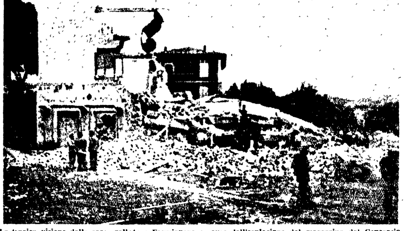
La tragica visione della casa crollata a Fermignano a causa dell'esplosione del magazzino del Consorzio
