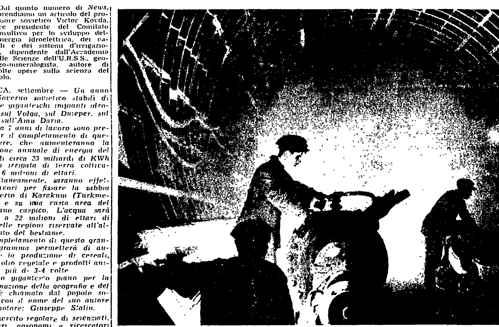
Sotto il corso del Don è in via di realizzazione questo largo tunnel, che rivestirà un importante ruolo nel quadro dei lavori per l'irrigazione di 750.000 ettari di terreno
