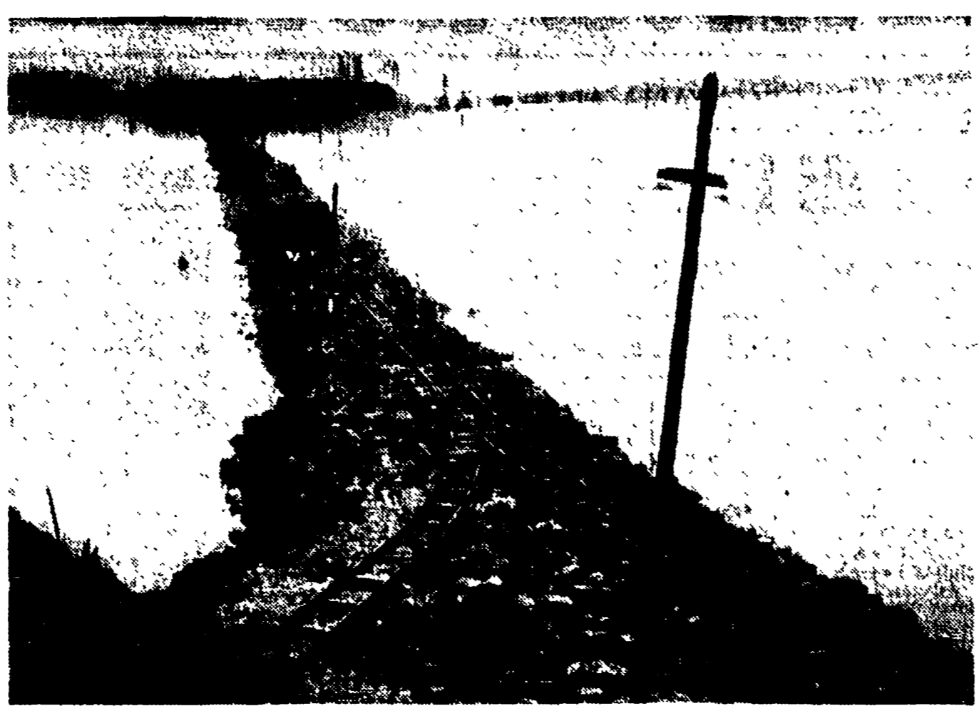
Ecco come è stata otturata dopo vari mesi la falla di Occhiobello. Una tralle coronella di sassi dovrebbe fare argine alle immani piene primaverili
