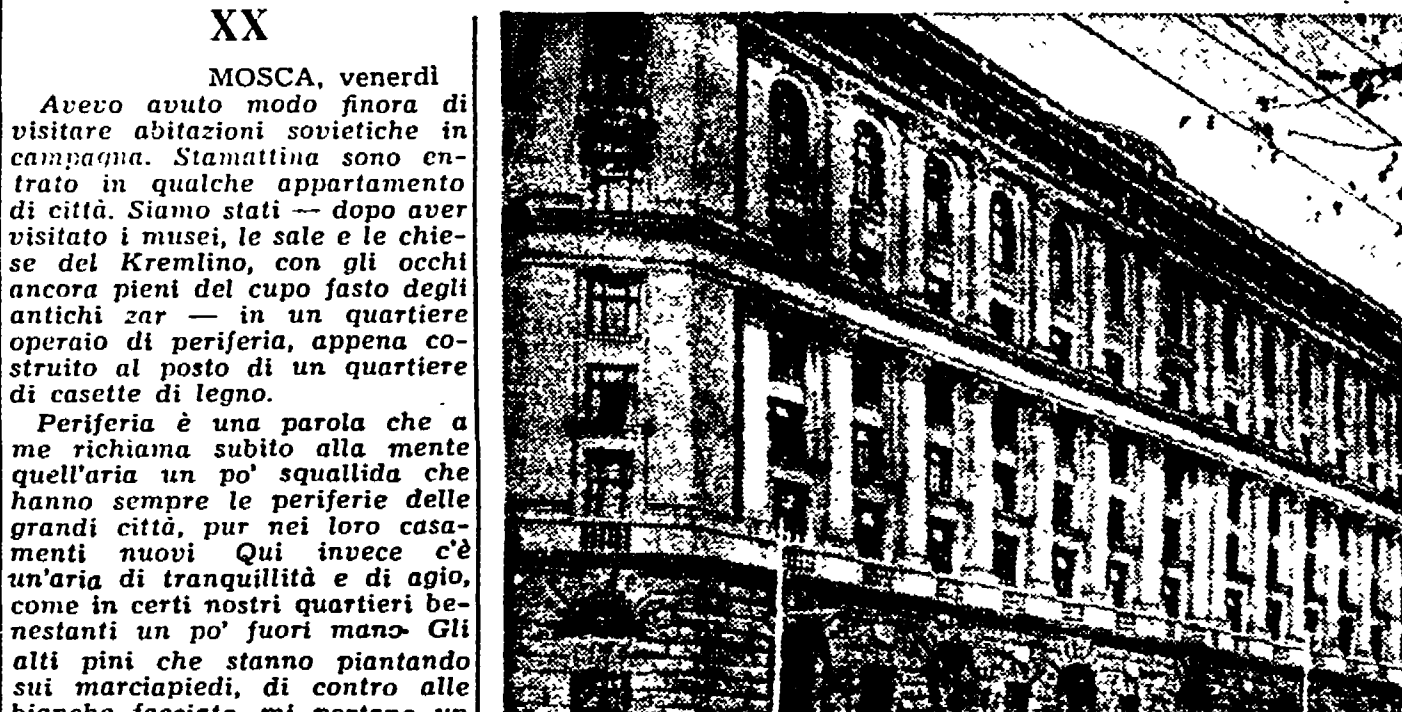
MOSCA — Edifici di recente costruzione lungo la via Gorki
