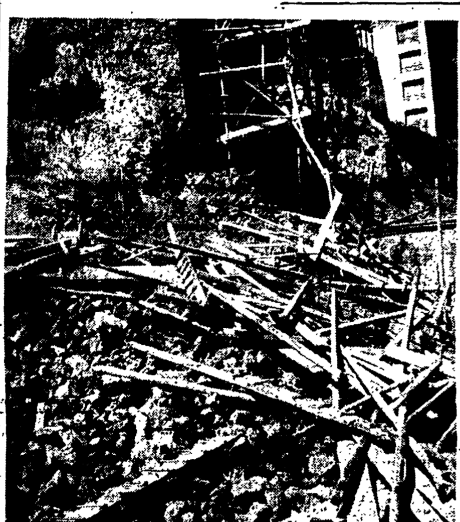
Ecco quanto è rimasto del muraglione, alto 15 metri e lungo 38, crollato ieri mattina a Trionfale.
