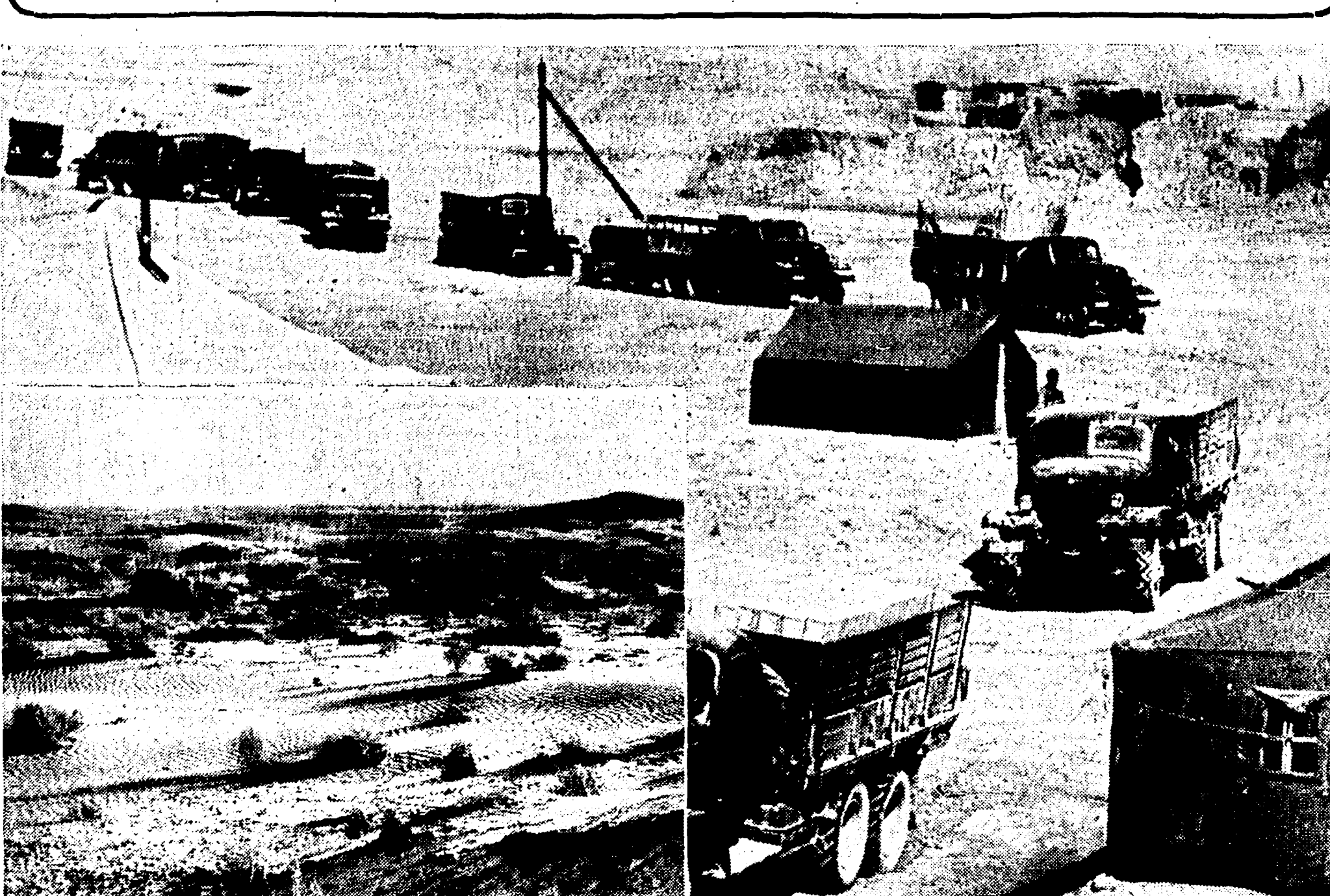
Interminabili autoconformazioni di giganteschi autocarri, vano delle officine sovietiche, solcano l'infuocato deserto del Kara Kum per rifornire i grandi cantieri adibiti alla costruzione del sistema idraulico che muterà l'attuale fisionomia del deserto.
