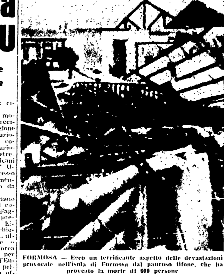
FORMOSA - Ecco un terribile aspetto delle devastazioni provocate nell'isola di Formosa dal pauroso tifone, che ha provocato la morte di 600 persone
