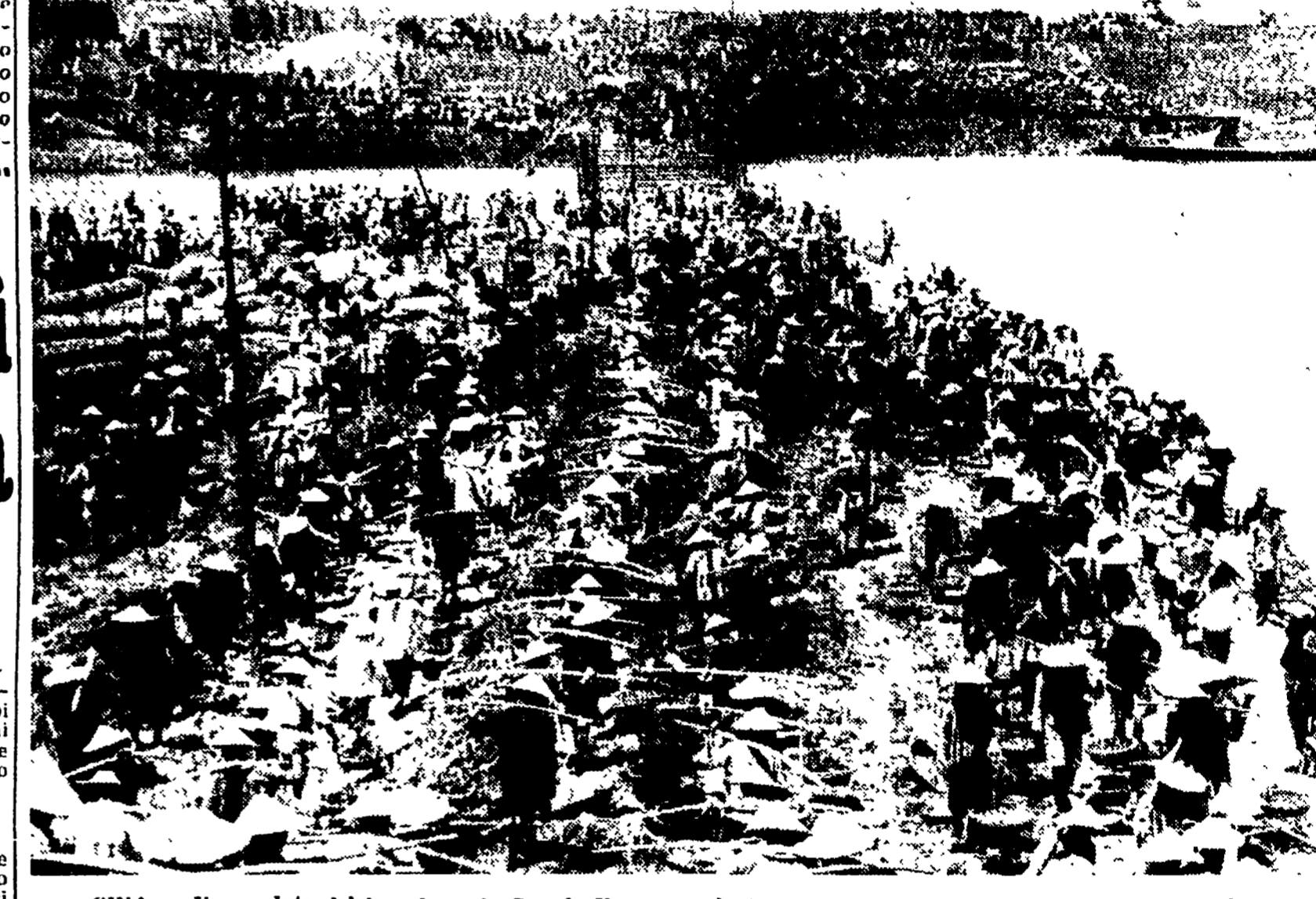
CINA — Una veduta dei lavori per la Grande Vena, quando la costruzione non era ancora giunta a compimento
