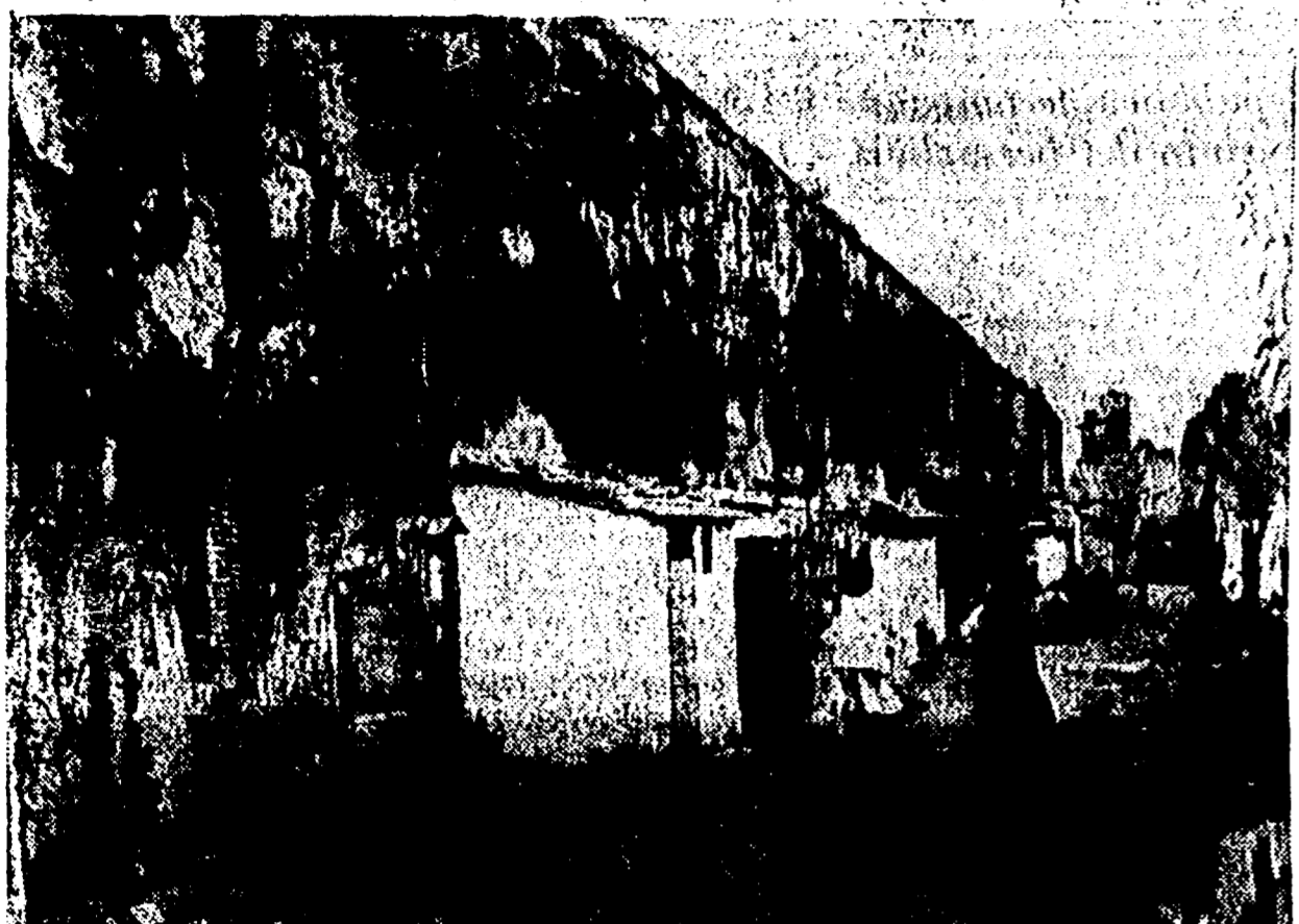
Il desolato aspetto delle «abitazioni» lungo l'Acquedotto
