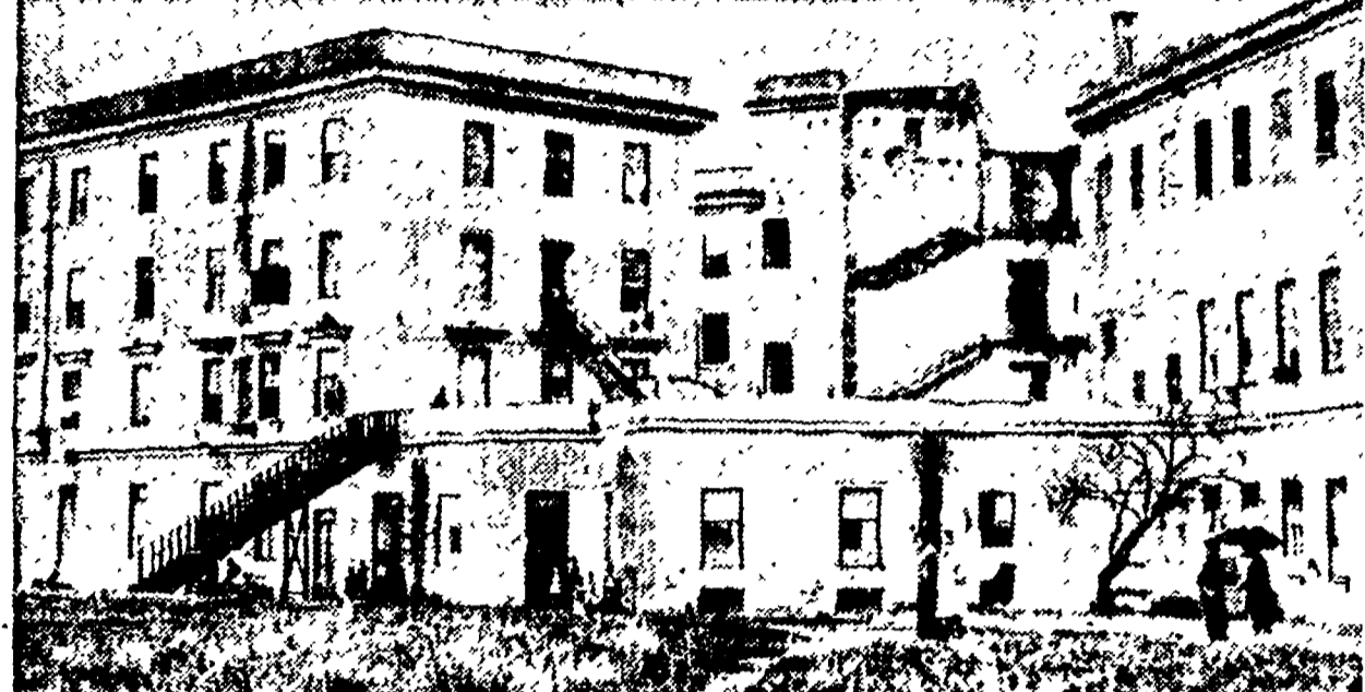
Le 125 famiglie che abitano in questo edificio che sorge nel paese di Ciampino, rimarranno senza casa centoventicinque famiglie.
