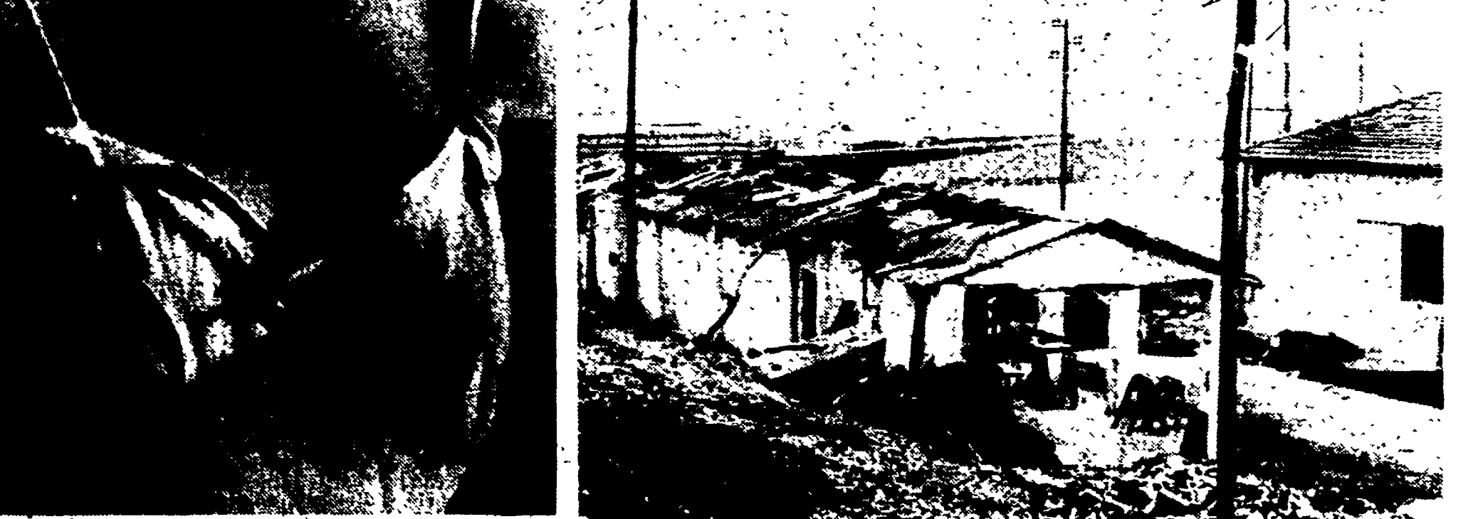
GALLICANO — Ecco come sono state ridotte le costruzioni situate in torno alla polveriera nel cui scoppio hanno troncato la morte dieci lavoratori.
