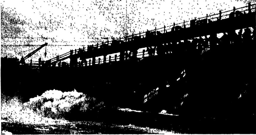
CINA - Un aspetto della grande diga ultimata nel 1952 nel Kiangsu settentrionale. La diga regola il volume e il livello delle acque di due grandi canali (il principale dei quali è lungo 170 chilometri) che servono all'irrigazione di centinaia di migliaia di ettari e a raccogliere le acque di innumerevoli piccoli fiumi e torrenti che per secoli avevano provocato continui disastri e inondazioni nella pianura del Kiangsu settentrionale
