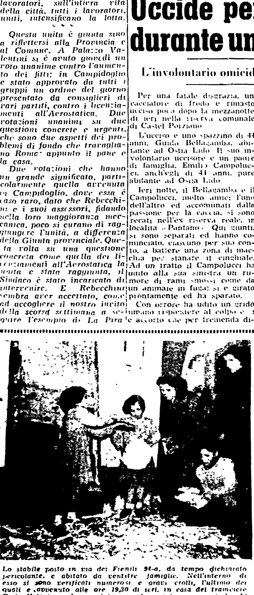
Lo stabile posto in via dei Fiumi 38-a, da tempo dichiarato pericolante, è obitato da ventisei famiglie. Nell'immagine sono visibili i danni causati dal fuoco che si è esteso alle ore 19,30 di ieri, in casa del transigente Carlo Valentini, che in abito con la moglie e sei figli, è crollato, come si vede nella fotografia, un soffitto.
