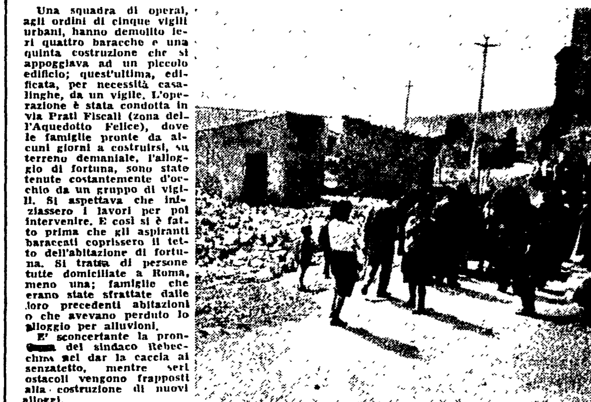
Prima fate le case poi demolite le baracche!
