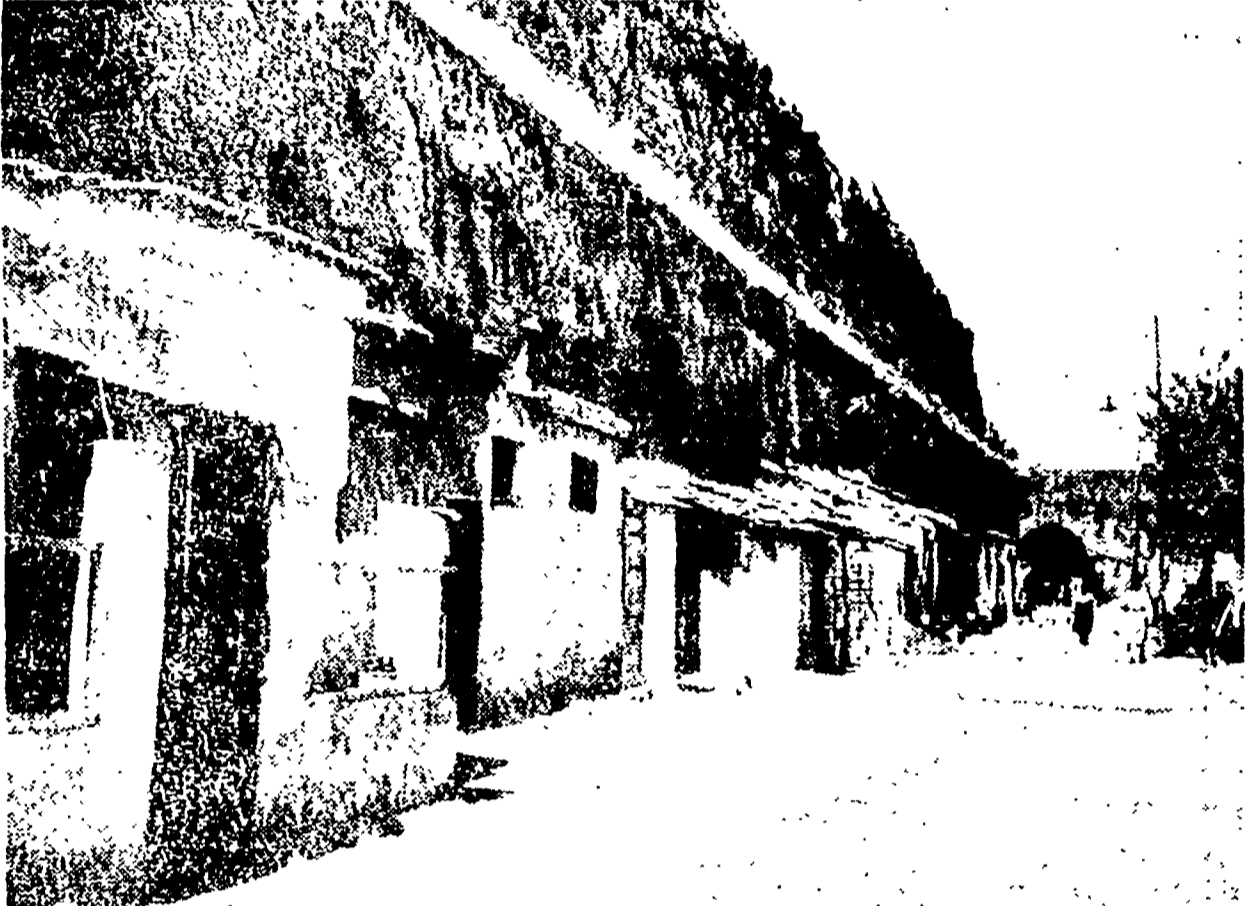
Baracche addossate a un antico acquedotto romano nella zona del Quadraro. Non molto lontano, nelle zone di Cinecittà e dell'EUR, hanno luogo una serie di speculazioni sui terreni
