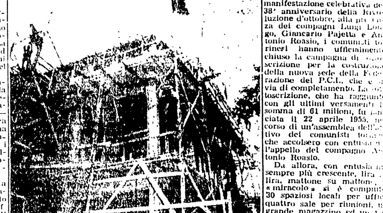
TOURNO - La nuova sede del Partito in costruzione
