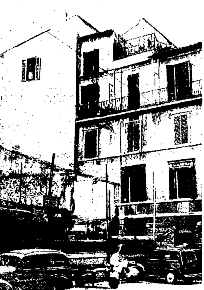
IN PERICOLO - Lo stabile di via Leonina visto dal lato sul quale sorge il cantiere che ha aggravato le lesioni già esistenti
