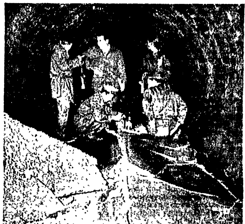
PESCHIERA — Questo è un tratto della galleria nei pressi di Morlupo, dove la platea è risultata dissestata per la lunghezza di 50 metri. La foto mostra tecnici ed operai nel corso dei sopralluoghi effettuati alla fine della scorsa estate
