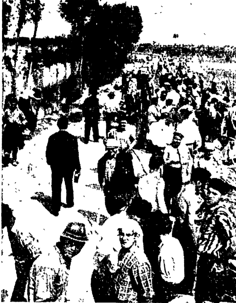
CA' VENDRAMIN — Squadre di volontari mentre lavorano per rafforzare gli argini poco prima della rotta
