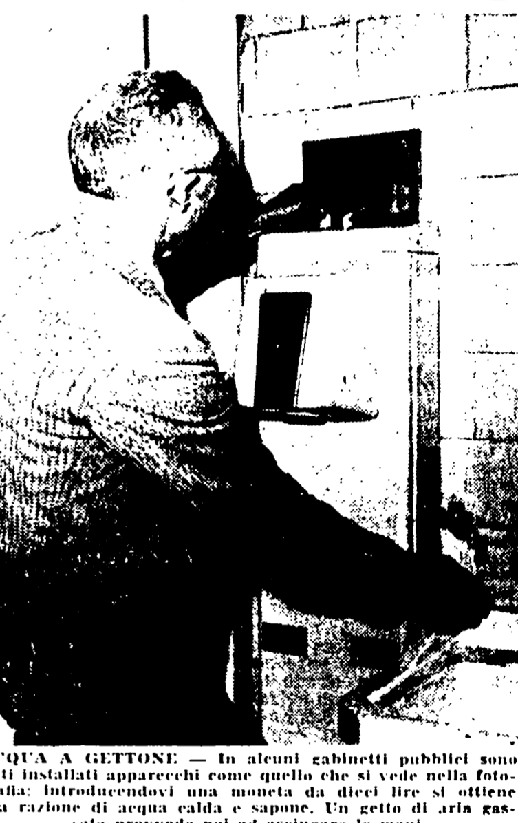
ACQUA A GETTONE - In alcuni gabinetti pubblici sono stati installati apparecchi come quello che si vede nell'ottorina. Introducendo una moneta da dieci lire si ottiene una razione di acqua calda e sapone. Un getto di aria compressa provvede poi ad asciugare le mani
