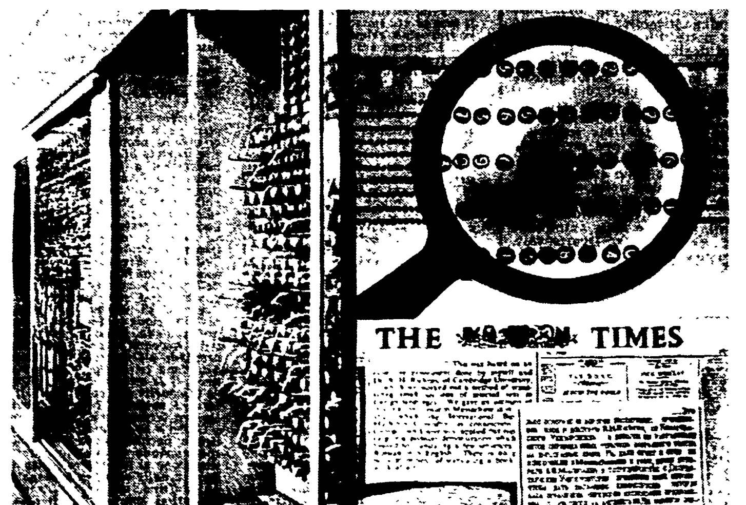
Questa calcolatrice elettronica è stata costruita dall'Istituto per la meccanica di precisione e per la tecnica del calcolo dell'Accademia delle scienze dell'URSS, diretto dall'accademico Lebedev. La calcolatrice, che si chiama BESM, è in grado di eseguire 8.000 operazioni aritmetiche al secondo, di risolvere equazioni con centinaia di incognite, di indicare la mossa giusta in un problema di scacchi. Con l'aiuto della calcolatrice si possono anche fare traduzioni da una lingua all'altra: BESM utilizza un vocabolario e una serie di regole grammaticali che sono state introdotte nella sua «memoria» sotto forma di speciali combinazioni di cifre. Ecco (a destra) un brano del «Times» tradotto in russo da BESM
