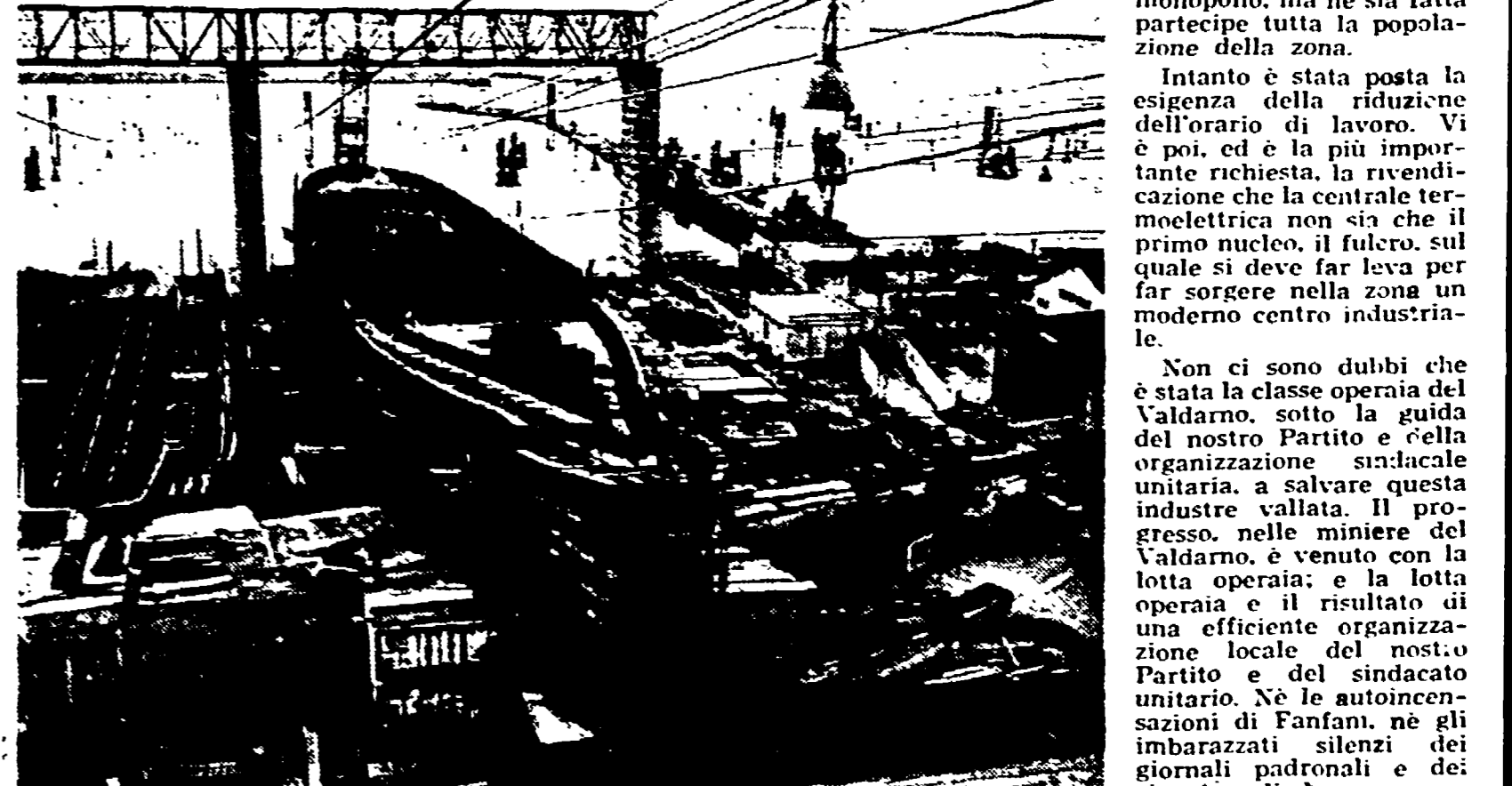
GENOVA — Una suggestiva veduta del cantiere «Ansaldo» con un progetto in costruzione. L'«Ansaldo» è un cantiere di grandi dimensioni e di smobilizzazione. I lavoratori si batteranno energicamente in difesa del loro lavoro e affermeranno che l'«Ansaldo» poteva vivere e svilupparsi.
