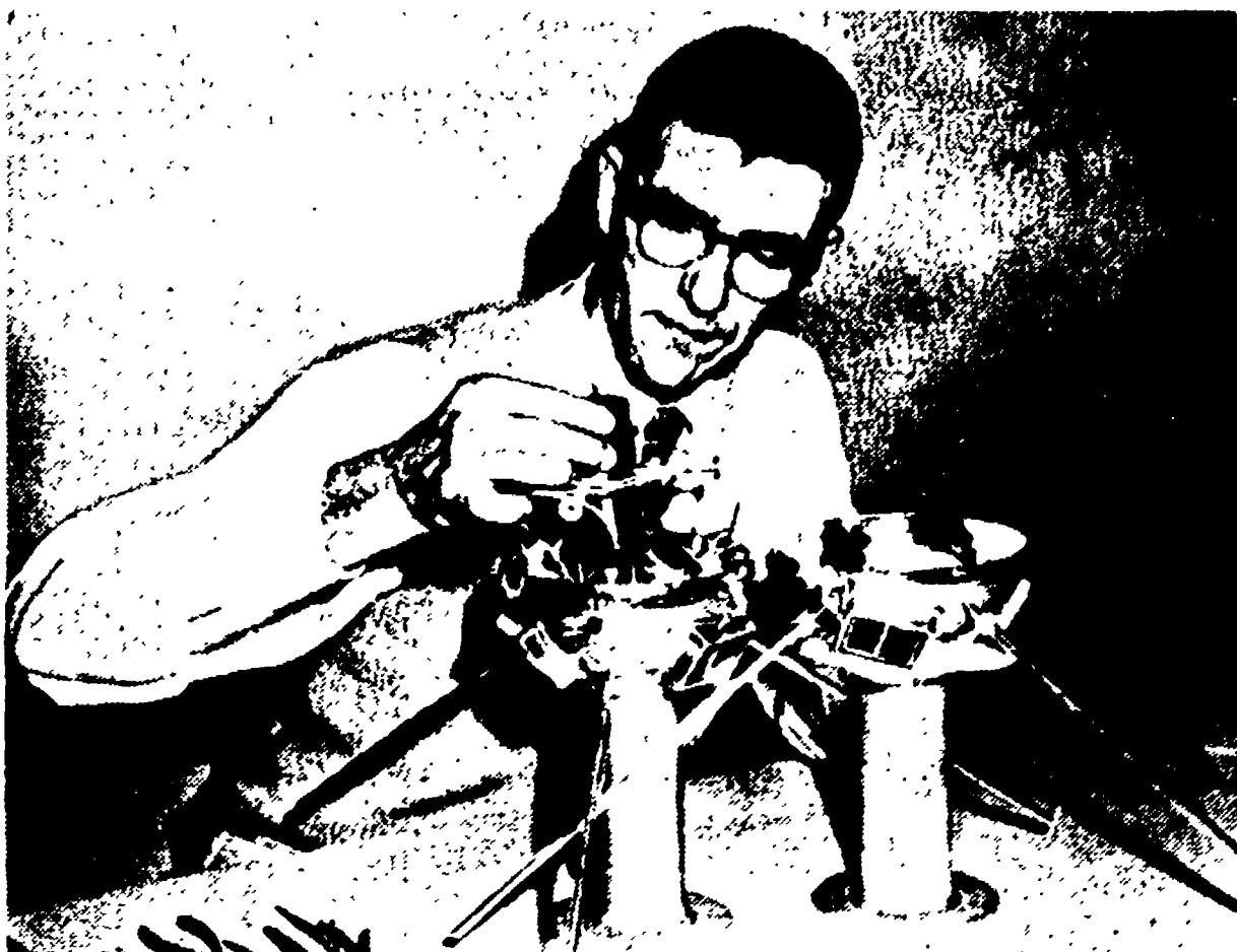
CAPE CANAVERAL - Il tecnico specializzato David R. V. Corbin, del laboratorio ricerche della marina, mentre inserisce un piccolo involucro contenente strumenti in una piccola sfera. Le piccole sfere contengono due trasmissioni radio, formate in maniera, una azionata da batteria a mercurio e l'altra a batterie solari; quest'ultima è collegata fuori della sfera. Le sfere verranno poi alloggiate nel satellite, le cui due metà si vedono appoggiate su un piedistallo. (Telefoto)
