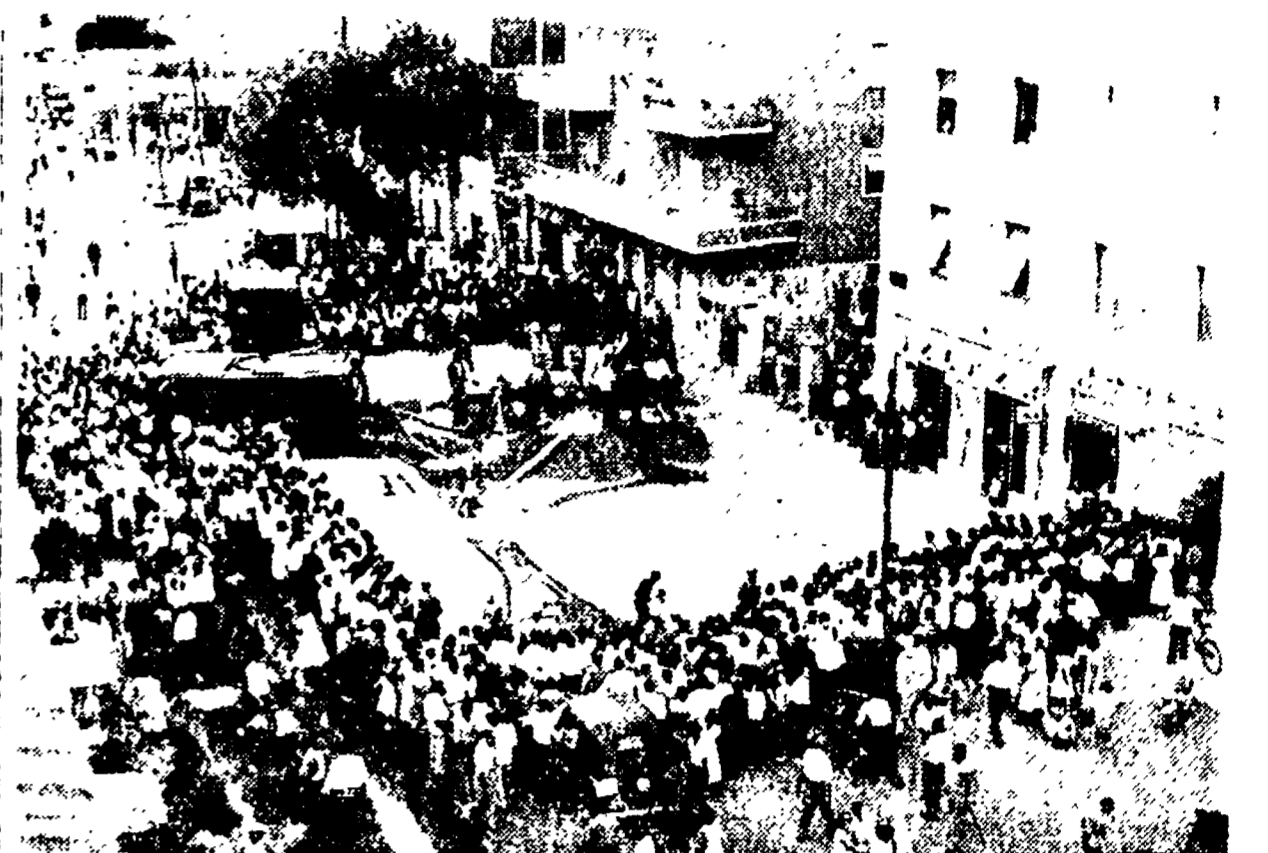
Una visione del posto dove si è svolta la terribile sciagura. La folla, ammantata, tratta una corda che si è rotta, mentre si tenta di salvare l'operaio
