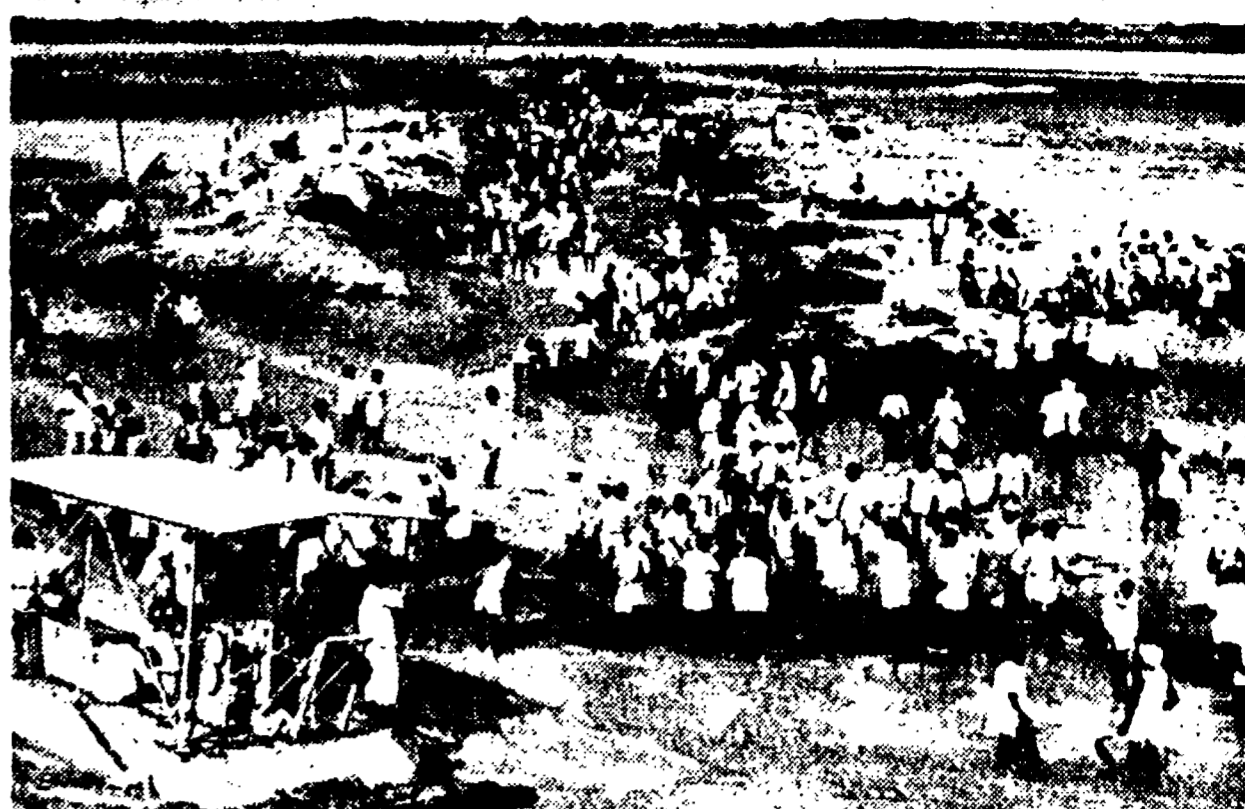
NUOVA DELHI - Migliaia di operai indiani lavorano alla costruzione di un canale per avviare al periodo della siccità in seguito allo spostamento del letto del fiume Jamuna. (Telefoto)
