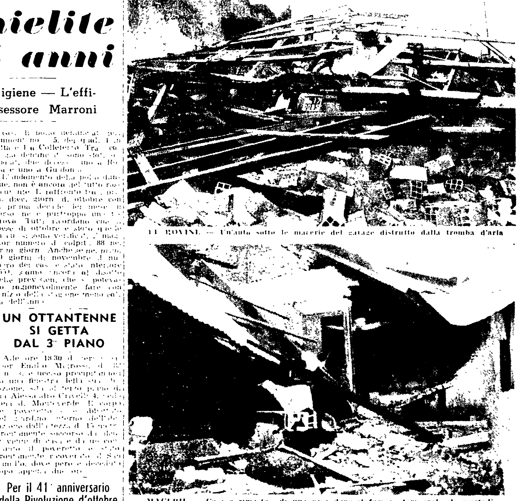
LE ROVINE — Un'auto sotto le macerie del garage distrutto dalla tromba d'aria
