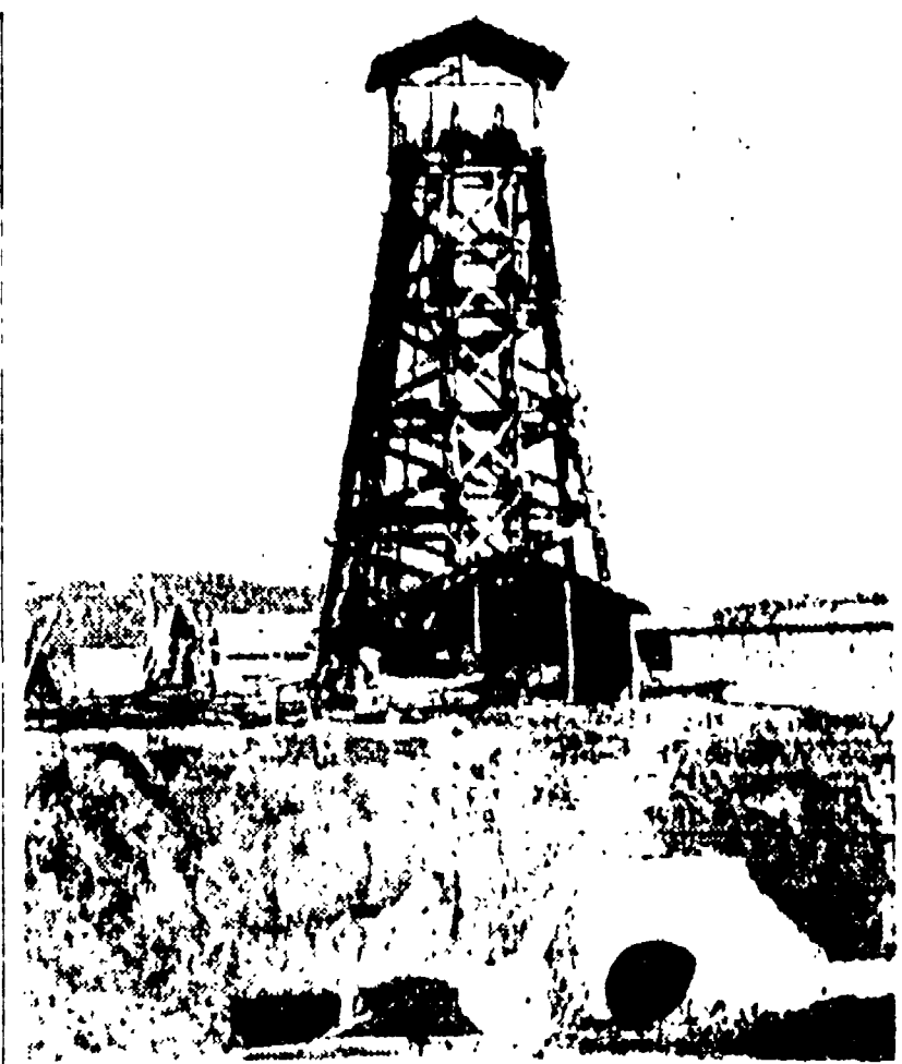
RIBOLLA - L'ingresso di un pozzo
