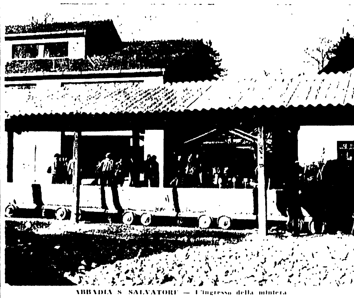
ABBADIA S. SALVATORE — L'ingresso della miniera
