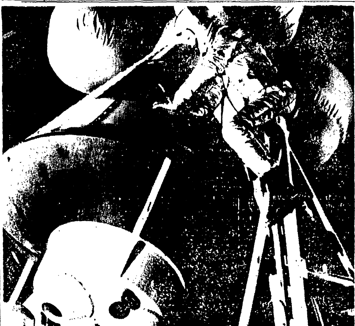
ST. LOUIS. — La prima foto della «capsula spaziale» costruita dalla « McDonnell Aircraft Corp. », mentre un pilota, completamente equipaggiato in tuta spaziale, si appresta ad entrare nella sua cavità. Ai lati sono visibili i collegamenti ad aria che servono per la stabilizzazione nell'atmosfera e per il galleggiamento al momento della ricaduta in mare. (Telefoto)
