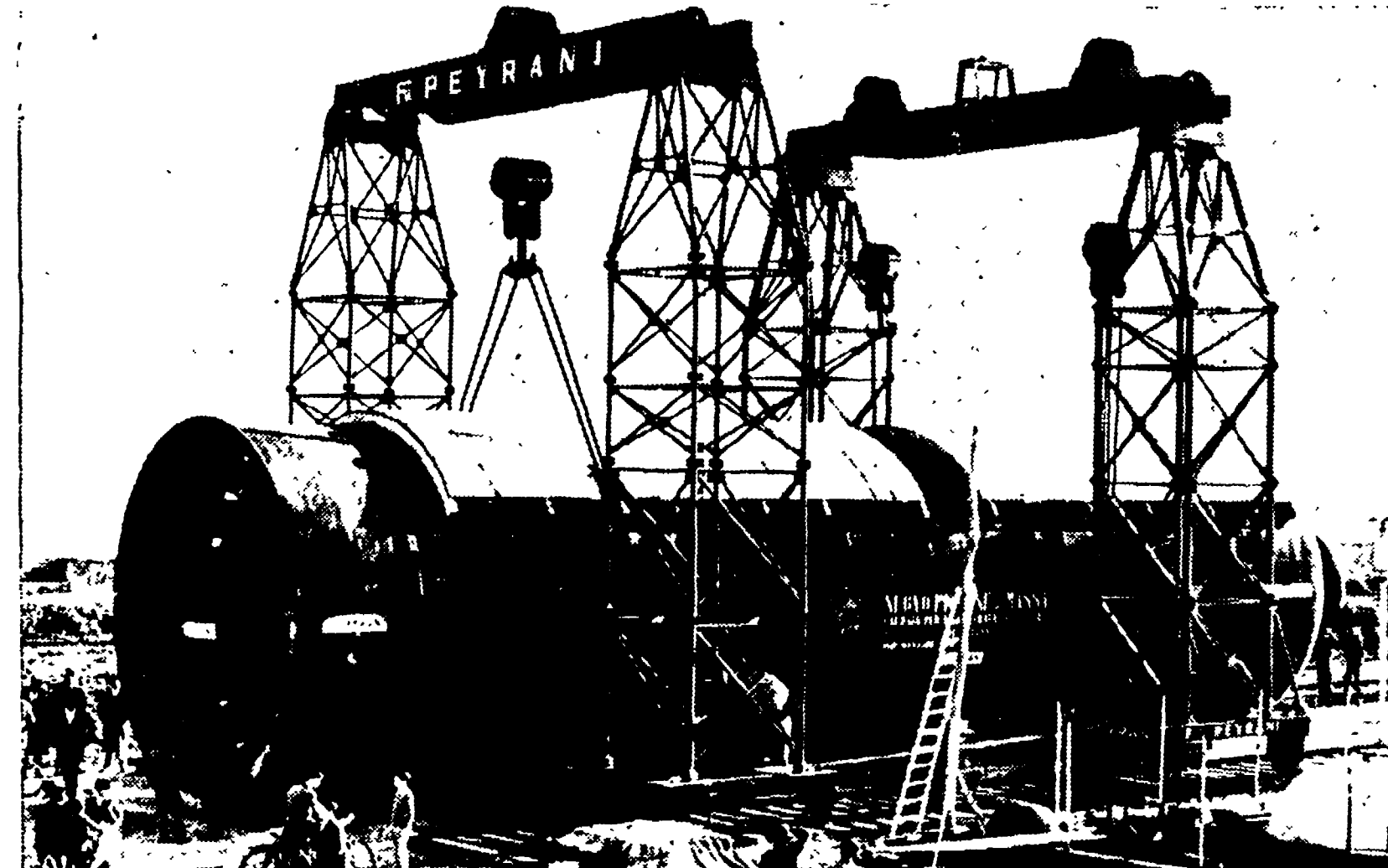
MASSA CARRARA — Al «Nuovo Pignone» sono stati costruiti i primi due scambiatori di calore del sel destinati alla centrale elettronucleare di Latina. Le caldaie di gigantesche dimensioni saranno varate su appositi carrelli a Marina di Massa e rimorchiata via mare fino al lido di Latina
