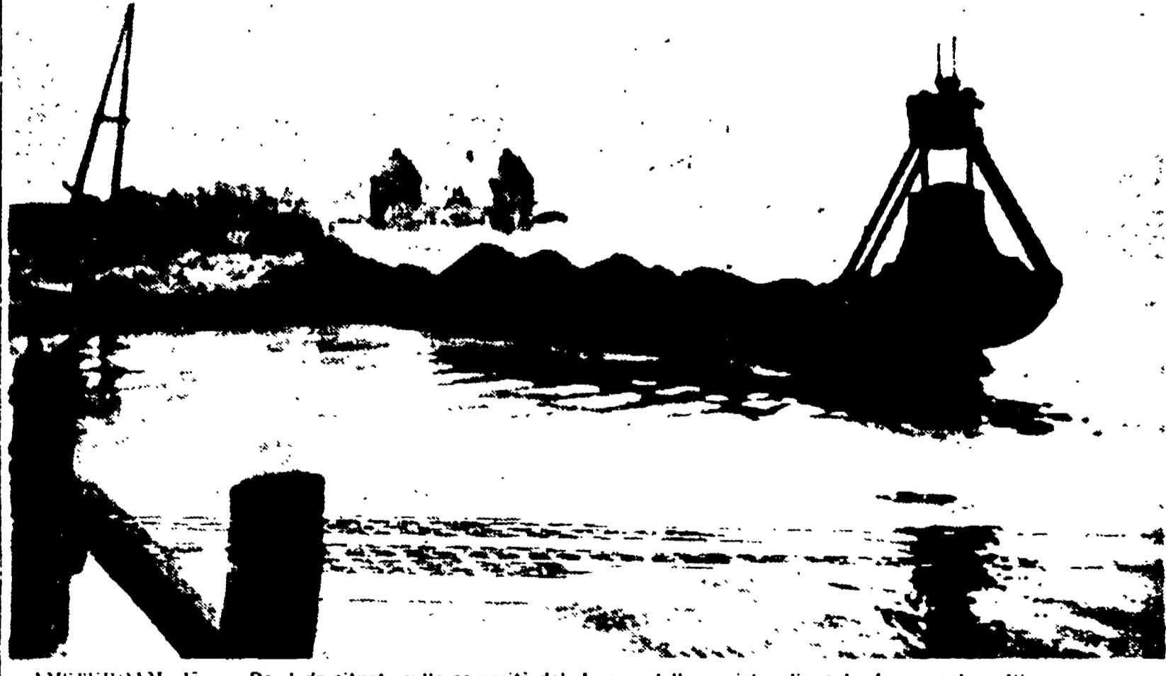
AMSTERDAM, 15. — Dopo 36 ore di accanito lavoro nel corso del quale sono stati adoperati da 8 a 10 mila metri cubi di sabbia, nel sobborgo di Tuindooop-Costanzaan, sommerso dalle acque, la breccia è stata finalmente colmata. Alle sette di ieri sera il livello era giunto, sul canale, a un metro e mezzo, ma fortunatamente già otto degli oltre 10 mila abitanti di Tuindooop-Costanzaan, si erano messi in salvo. Gli altri invece sono rimasti durante tutta la notte a gelare sui tetti al buio. Ad evacuazione ultimata il borgomastro ha comunicato che ci sono 11.240 senza tetto, mentre le case inondate sono 2600.
