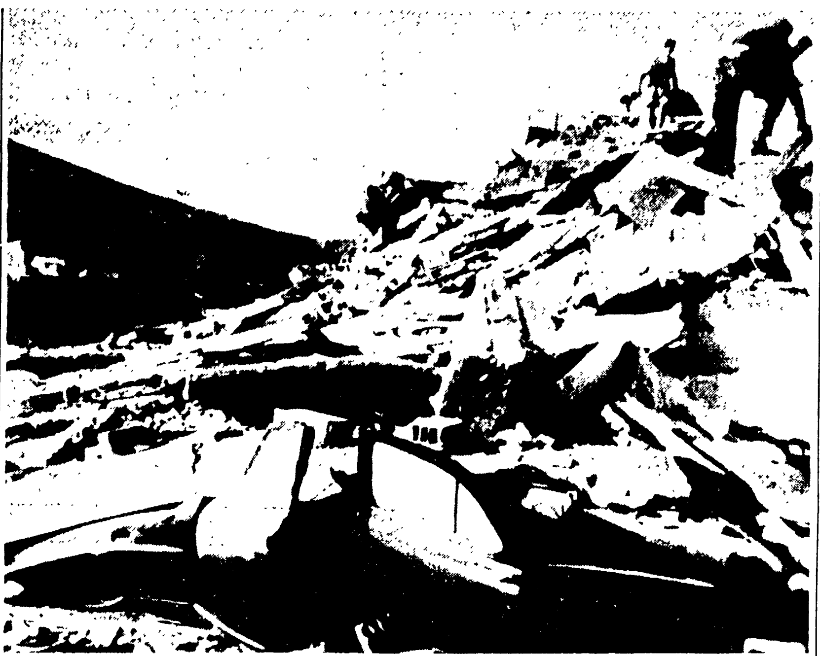
AGADIR — Una terrificante veduta del disastro. In primo piano un'auto schiacciata dalle macerie (Telefoto)
