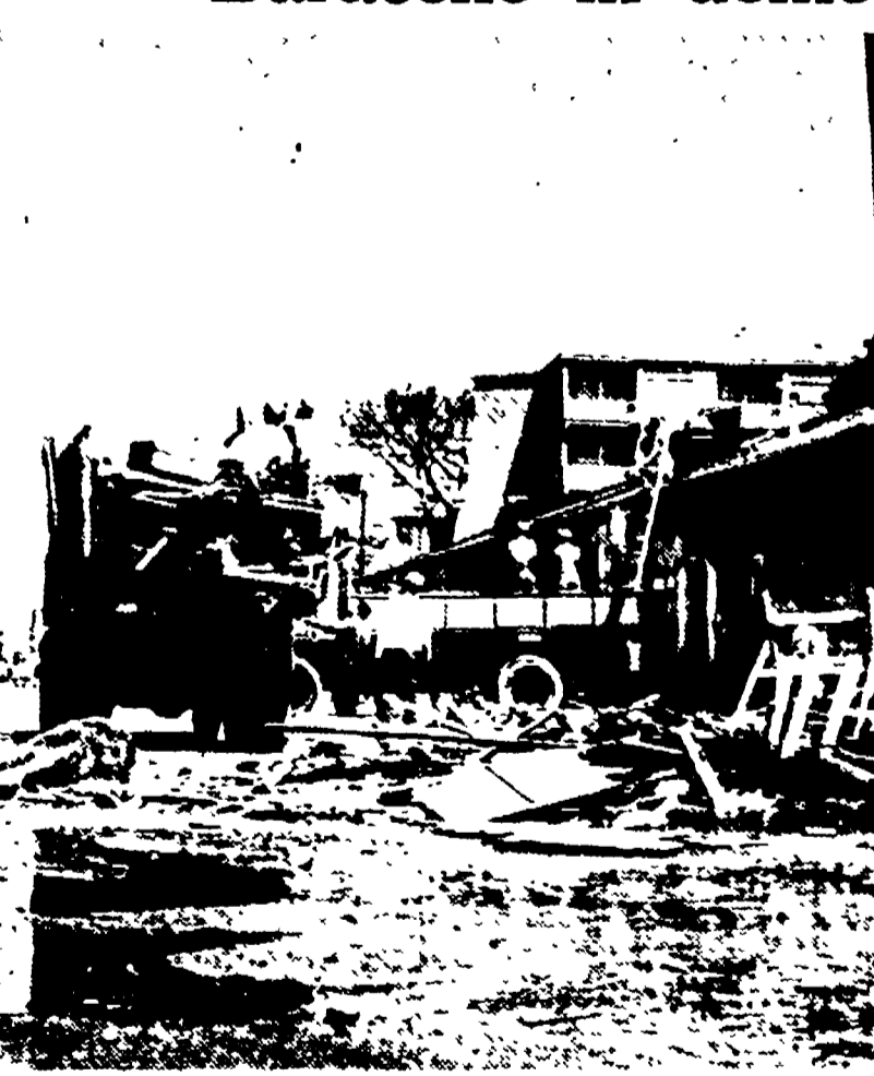
Sono iniziati i lavori di demolizione delle baracche della Circonvallazione Giamaica.
