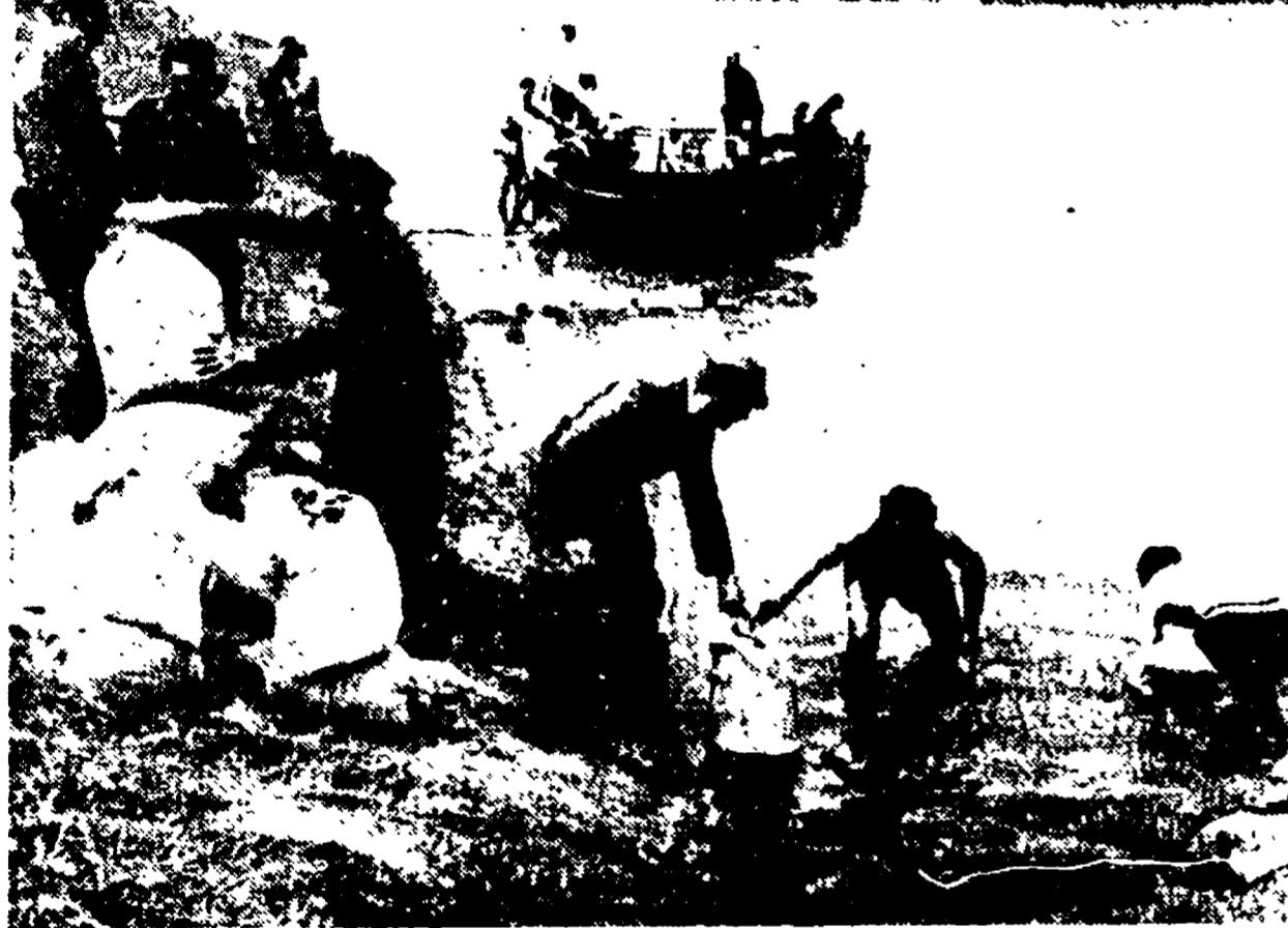
VARSAVIA - Un aspetto della lotta contro le inondazioni in Polonia. Soldati polacchi riempiono sacchi di sabbia per rafforzare gli argini del fiume Vistola...
