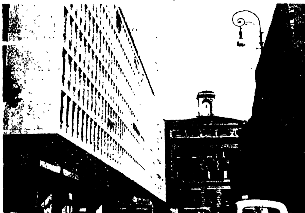
VIA PARIGI — Il nuovo palazzo per uffici costruito recentemente dall'Immobiliare. La realizzazione di un edificio come questo costituisce un nuovo punto di attrazione per un numero molto notevole di veicoli. Ma, per la mancanza di un piano di sistemazione della zona, le strade intorno sono rimaste inadeguate alle nuove esigenze e le difficoltà della circolazione e del parcheggio aumentano di giorno in giorno. La prima conseguenza è stata la distruzione del giardino pubblico di fronte al Planetario.
