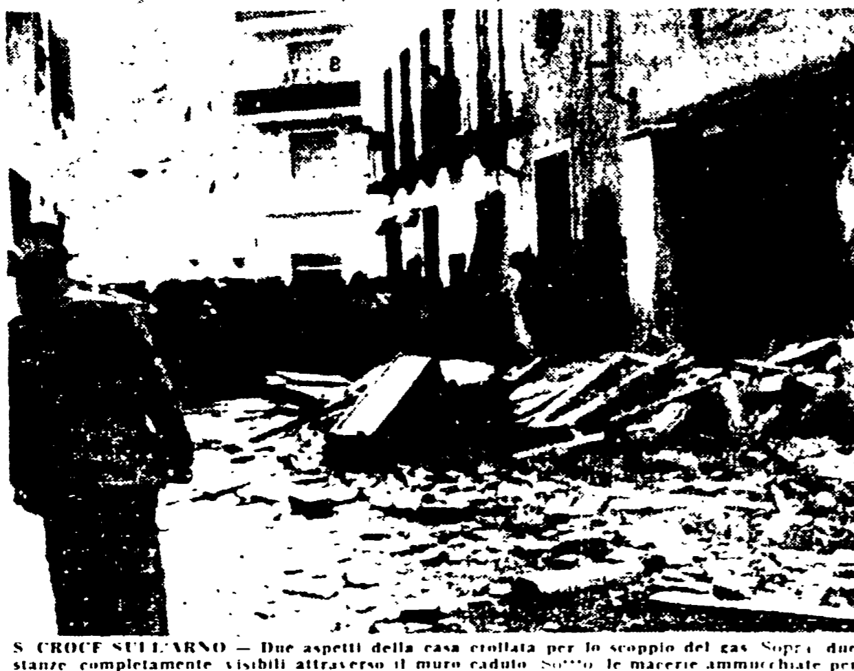
S. CROCE SULL'ARNO. — Due aspetti della casa crollata per lo scoppio del gas. Sopra: due stanze completamente visibili attraverso il muro caduto. Sotto: le macerie ammassate sulla strada.
