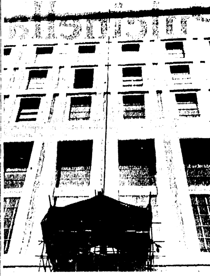
La foto mostra la profonda fenditura che, dall'alto fino alle fondamenta, è venuta fuori alla Farnesina...
