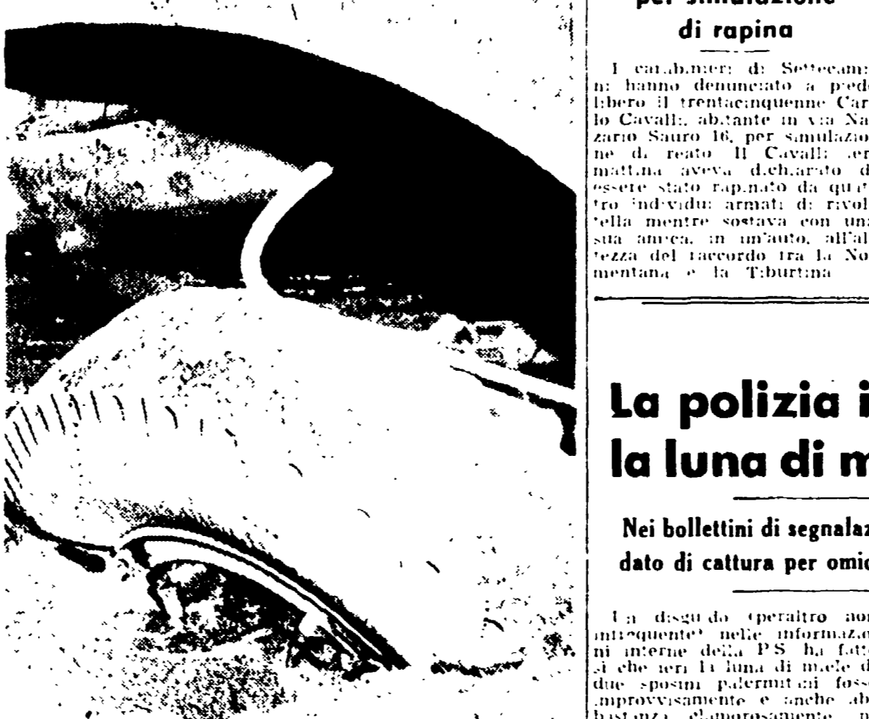
La ruota del camion nella voragine di via Cimarra
