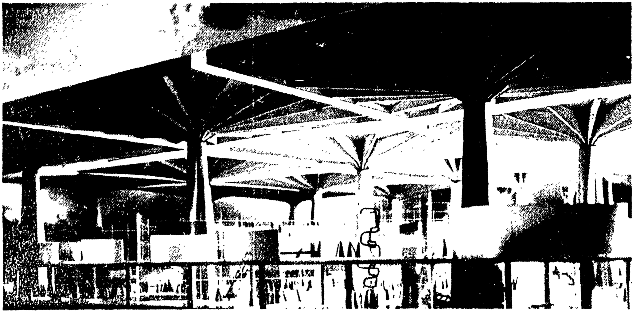
L'ampio parallelepipedo di vetro sostenuto da quattro grandi pilastri di cemento, progettato e costruito dall'ing. Nervi. L'ampio parallelepipedo di vetro sostenuto da quattro grandi pilastri di cemento, progettato e costruito dall'ing. Nervi. L'ampio parallelepipedo di vetro sostenuto da quattro grandi pilastri di cemento, progettato e costruito dall'ing. Nervi.
