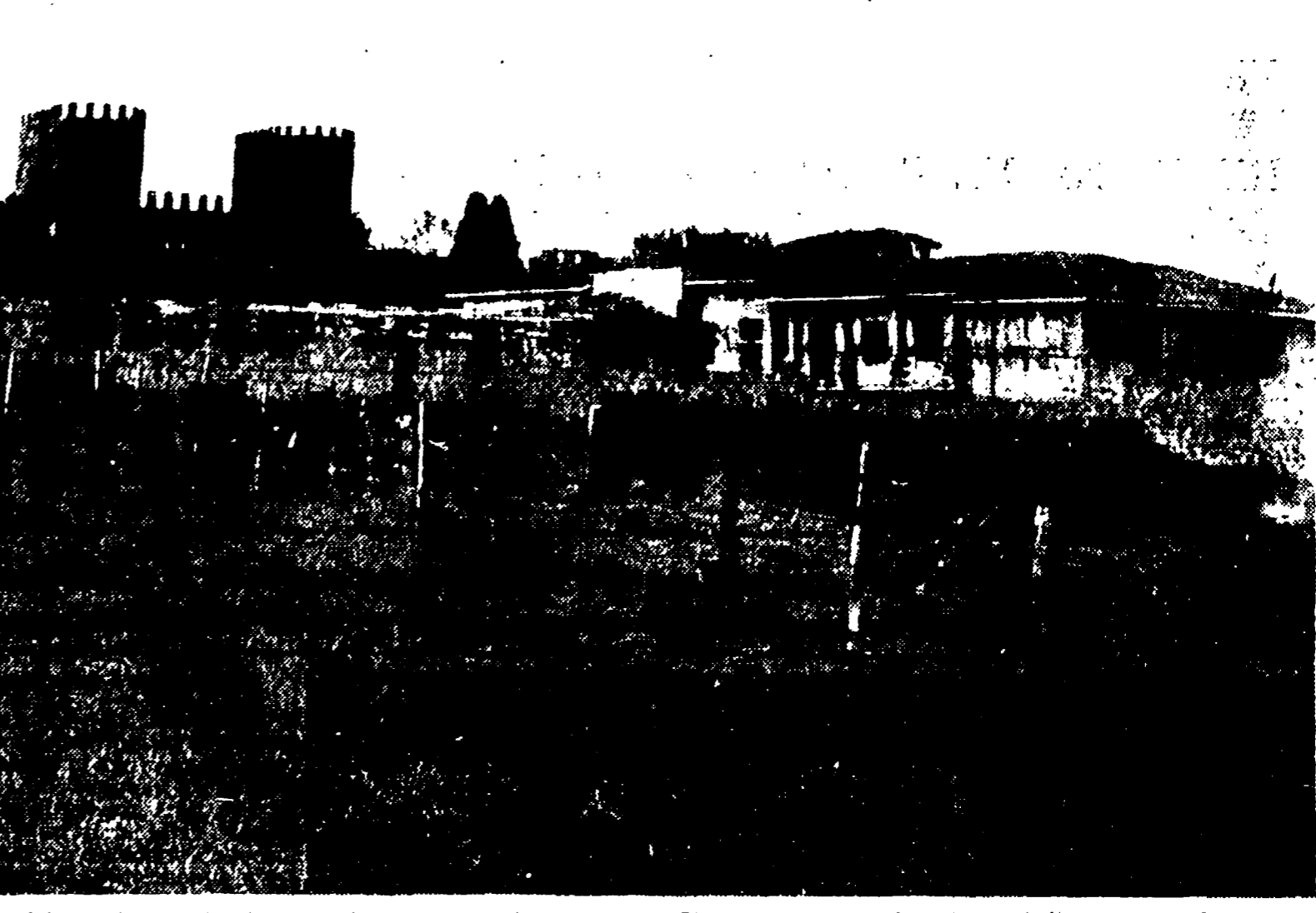
Una delle ultime costruzioni abusive sorte sull'Appia Antica. Si tratta di una villa nei pressi di porta San Sebastiano
