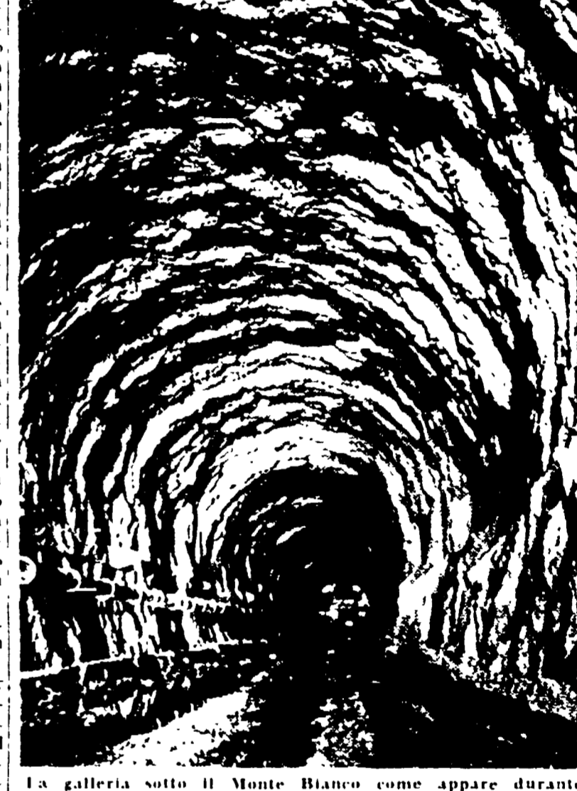
La galleria sotto il Monte Bianco come appare durante i lavori di perforazione.
