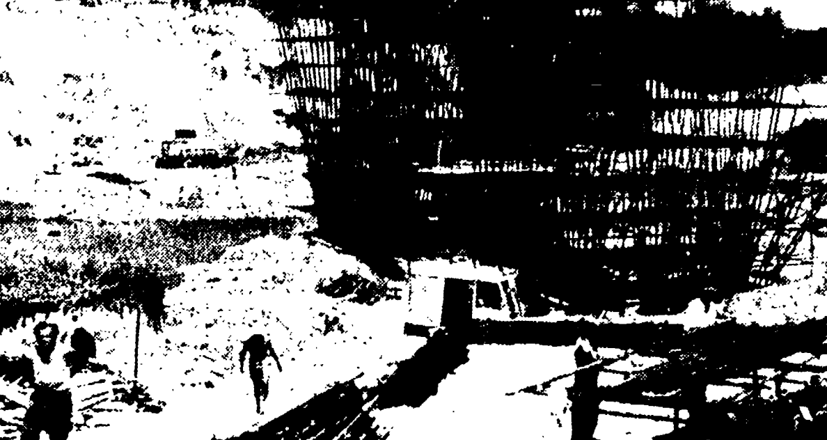
FIRENZE - Lavori in corso per il tratto a sud di Firenze, dell'Autostrada del Sole. Questo sono le prime centine del ponte di Bruscoletto presso Incisa Valdarno...
