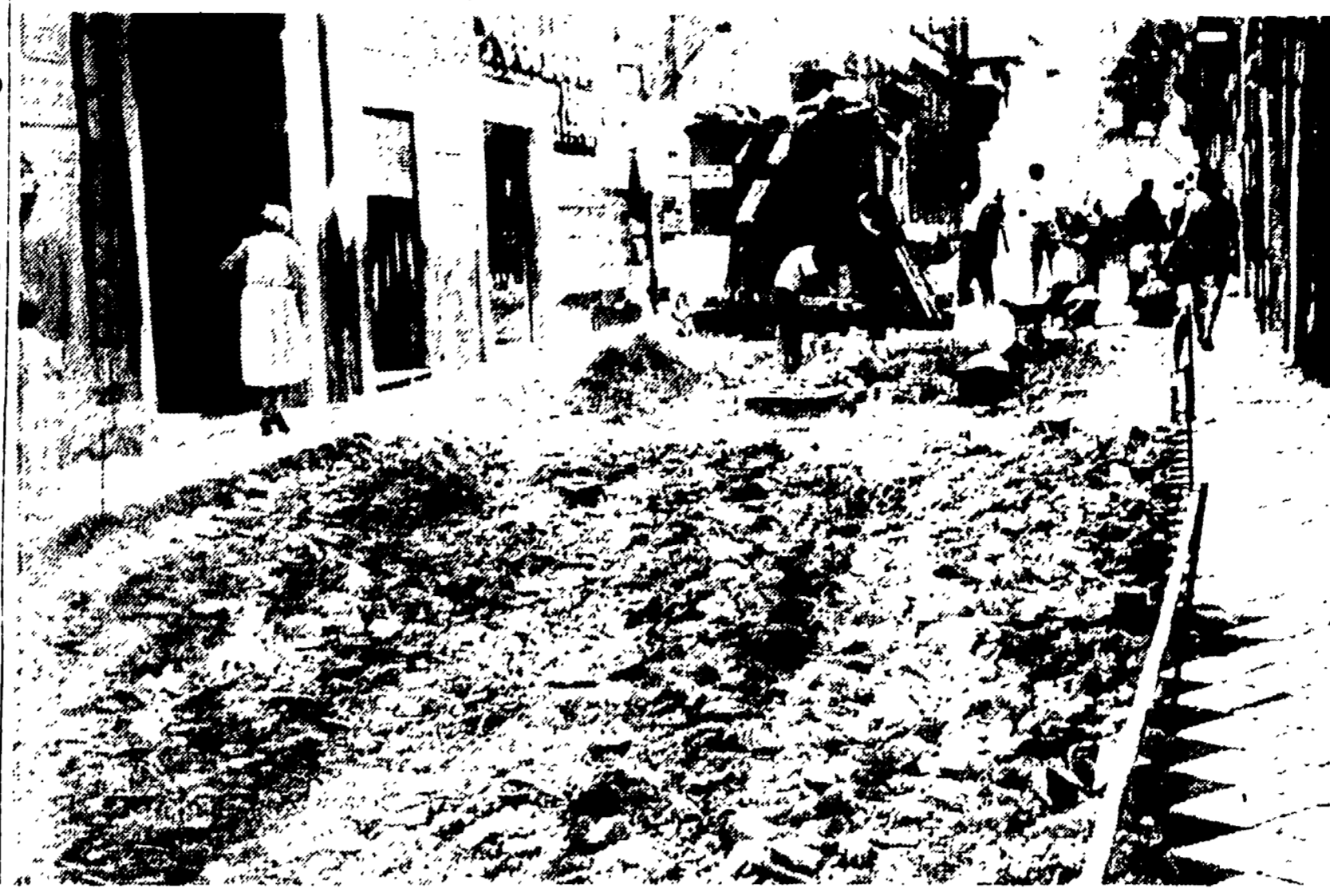
Da quattro mesi, via della Croce è ridotta all'essenziale di una trincea fra la sistemazione delle fogne e il riassetto delle tubature del gas e dell'acqua dal manto scarsi di selciato della corsola scassinata strada e un'interminabile scavo. Solo se opera, con turni ininterrotti, sono stati impiantati dal Comune per rimediare ad una situazione che per i commercianti che hanno i negozi al lato della via è assolutamente disastrosa.
