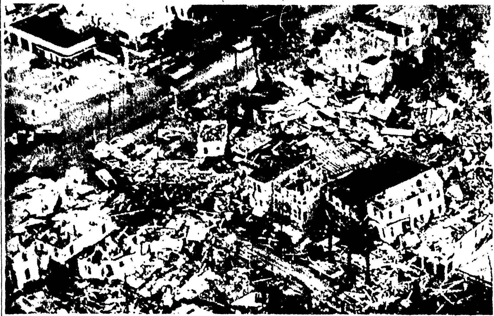
GALVESTON — Ecco ciò che è rimasto di un quartiere della città dopo il passaggio del ciclone (Telefoto)
